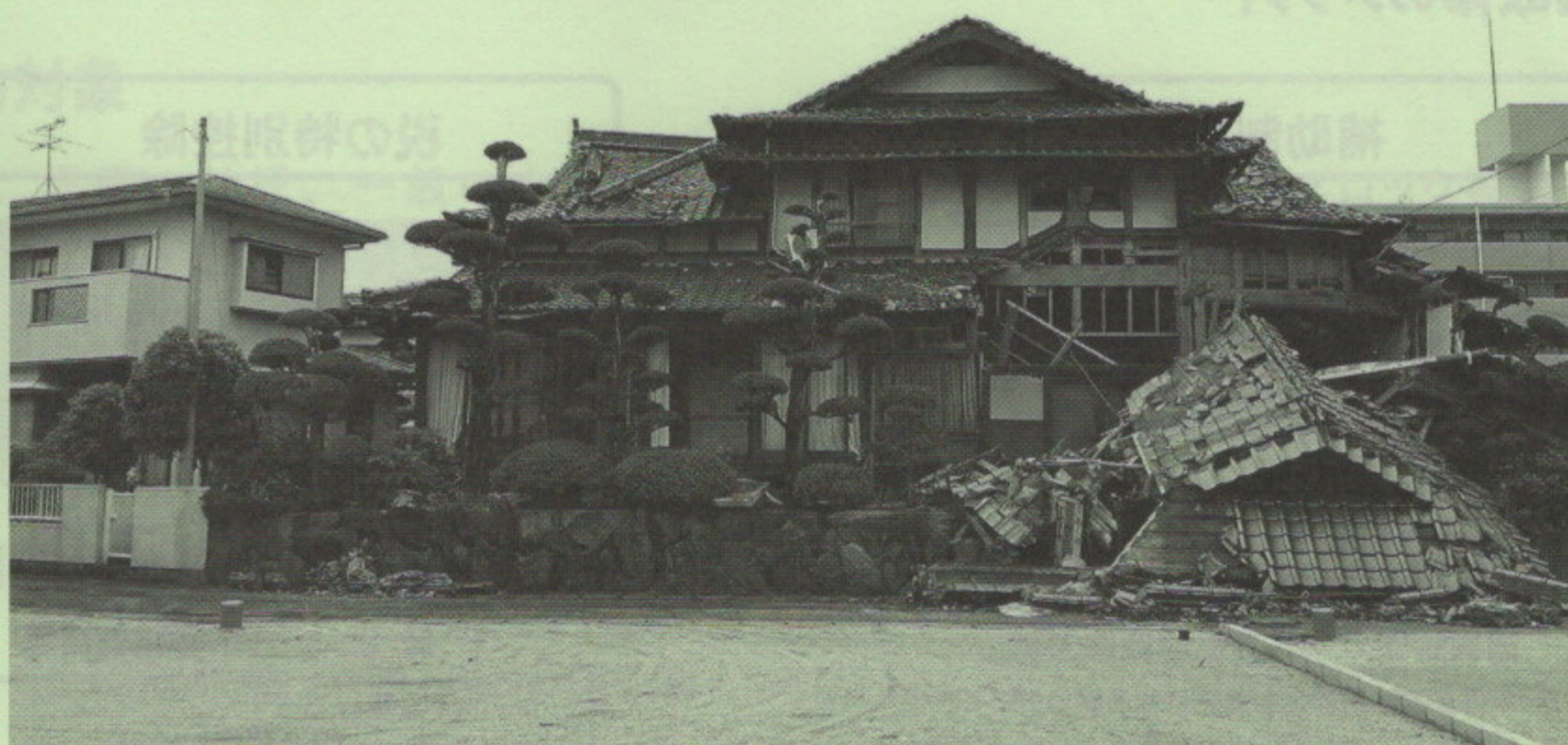
平成 28 年 熊本地震での被害状況
